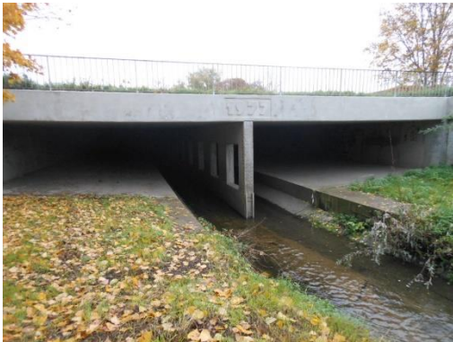
Zugang seitens Käsbrünnelestr. (Auslauf Schwippe)
