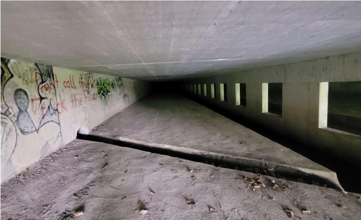
Für den Schutz der Wochenstube in der Schwippeverdolung sind Lärm- und Erschütterung vermeidende Maßnahmen erforderlich. Konkret wird vorgeschlagen, die Betonfenster beidseitig mit Holzverschalungen zu verschließen, wobei die Hohlräume mit geeignetem Dämmmaterial gefüllt werden sollen. Hierdurch wird die Schallausbreitung in die Schwippeverdolung erheblich reduziert.
