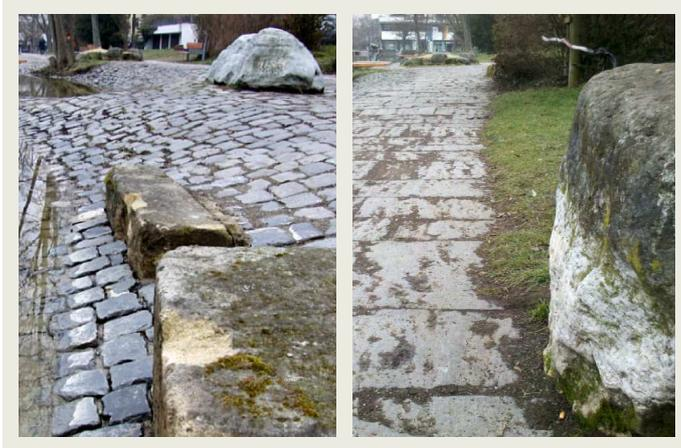
Steine, die Wind und Wetter ausgesetzt sind, verwittern. Dabei bildet sich häufig ein dunkler Belag an der Oberfläche, wie bei den Sandsteinen (links) und Kalksteinen (rechts) am Klostersee. An den Bruchstellen sieht man dagegen den frischen und unverwitterten Stein.
