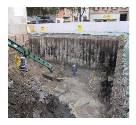
Auffüllung CKW Schaden im Boden und GW
