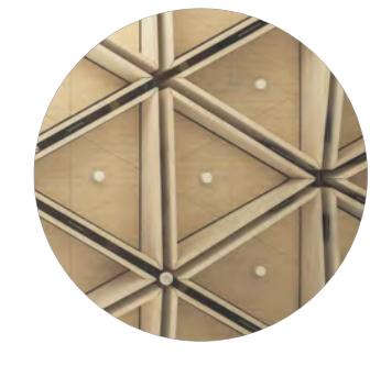
Holz-Kassettendecke (dreieckiges Trägergest)
