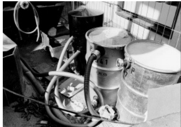
Abb. 21: Untere Vorstadt, CKW-haltiges Material wird abgesaugt und über Aktivkohlebehälter gereinigt. (Foto: Der größte Anteil des Bodens zeigte mittlere Belastungen. Da im unterirdischen Rohrvortriebsverfahren gearbeitet wurde, traten im belasteten Bereich auch Ausgasungen im Arbeitstunnel auf. Deshalb mußten zeitweise spezielle Schutzmaßnahmen getroffen werden, wie das Absaugen und Reinigen der Luft aus dem Arbeitstunnel und dem Einsatz von Atemschutzmasken für die vor Ort tätigen Arbeiter.
