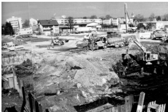
Abb. 22: Laufende Aushubarbeiten bei IKEA (Foto: BWU, Kirchheim/Teck)
