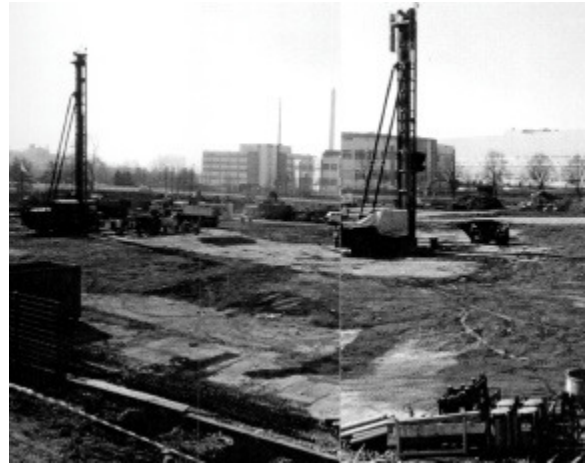
Abb. 23: Beginn der Gründungsarbeiten bei IKEA (Foto: BWU, Kirchheim/Teck)
